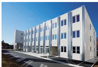
令和元年～ 国際寮の建設 （茨城：国際寮）
