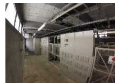
旭川高専 低圧配電盤設備更新整備
