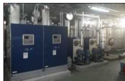
函館高専 ボイラー更新整備
