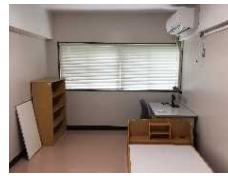
富山高専(本郷) 留学生の居住環境整備 【寄宿舎4号館内部改修】
