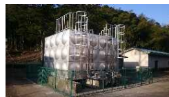
舞鶴高専 受水槽更新整備
