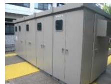
新居浜高専 屋外変電設備更新整備
