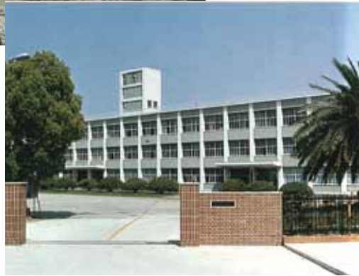
【明石】上：昭和 37 年、工事中の本校舎 下：正門から現在の校舎を望む
