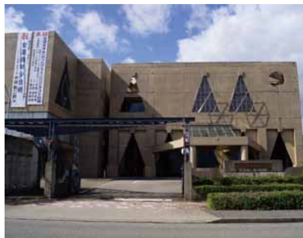
【金沢高専】正門付近
