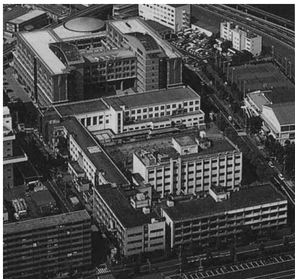
【東京都立工業高専】旧校舎(手前)と新校舎(奥) (渡辺 和人)
