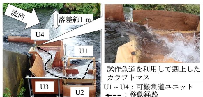
図4 試作魚道システムと遡上の様子
