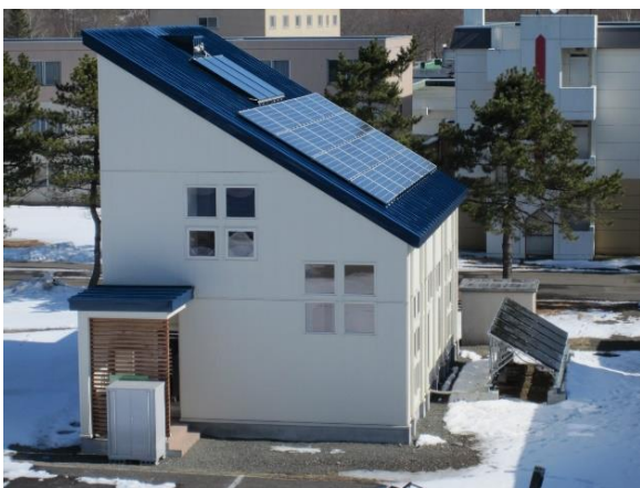
太陽光発電モジュール(2kW+4kW)
