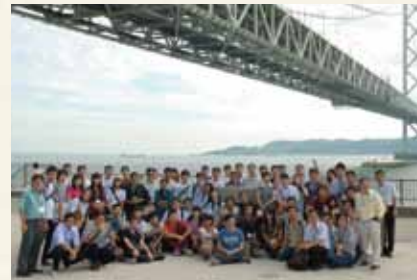
▲明石海峡大橋の見学
