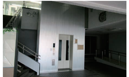
車椅子に対応したエレベーター、スロープの設置（沼津高専）
