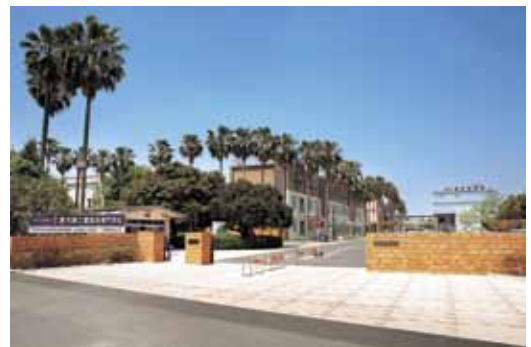
【鹿児島】改修工事を終えたばかりの正門から
