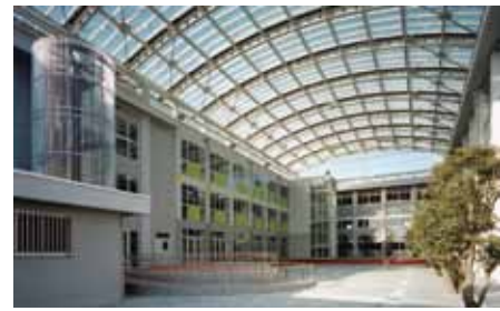
上【松江】アメニティ&コミュニケーションの空間「学びの庭（アーケード）」 左【弓削商船】救命艇やカッターなどを収容する実習船係留場
