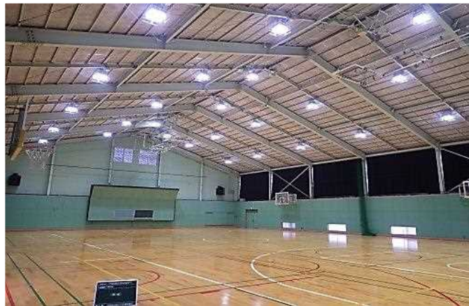
【第2体育館】 照明に落下防止ワイヤーを施しLED化。
