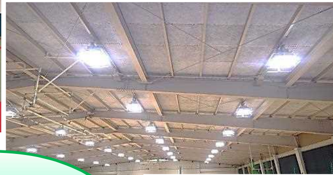
【第1体育館】 照明に落下防止ワイヤーを施しLED化。
