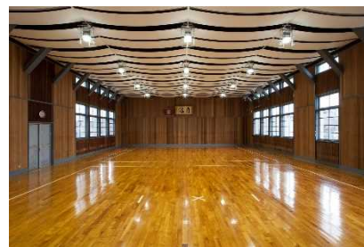
施工後（天井貼替、照明器具取替等）
