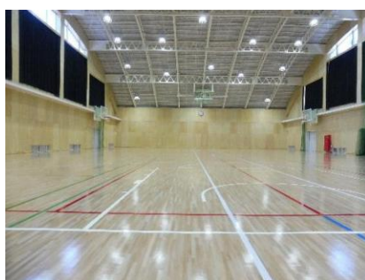
徳山高専：体育施設改修
