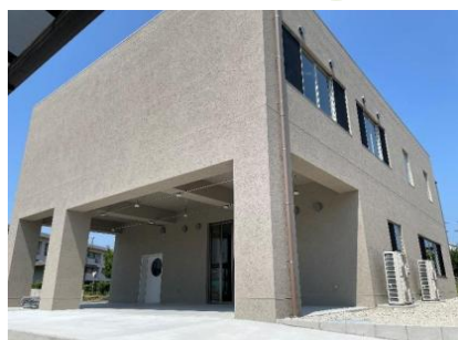
明石高専：実習棟改築
