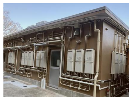
佐世保高専：給湯設備更新
