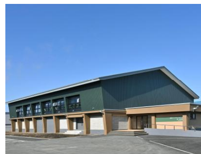
釧路高専：体育館改修
